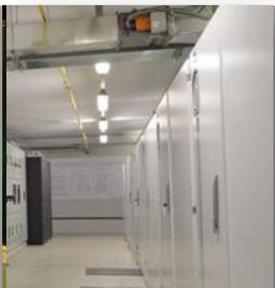
Во всей системе электропитания ЦОД НИЦ «КИ» используется оборудование Eaton: начиная от вводных автоматических выключателей и заканчивая питанием конечных серверов. **В систему вошли порядка 230 панелей Eaton xEnergy** с автоматическими выключателями IZM, на токи от 2000 А до 4000 А, а также выключатели NZM - на токи от 20А до 1600 А.
